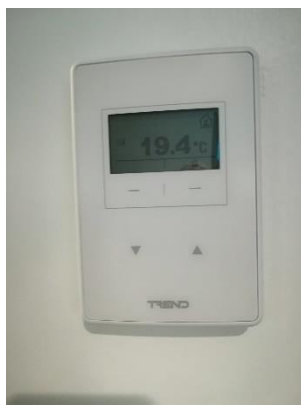
Figur 1-21 Temperatursensor til væginstallation. Kilde: forfatteren
